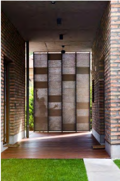
Figur 13 - Gennemskinnelig beton som læskærm
