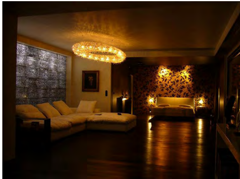
Figur 14 - Gennemskinnelig beton som skillevæg
